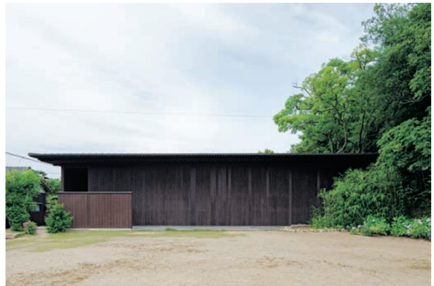
家プロジェクト「南寺」 Art House Project Minamidera
