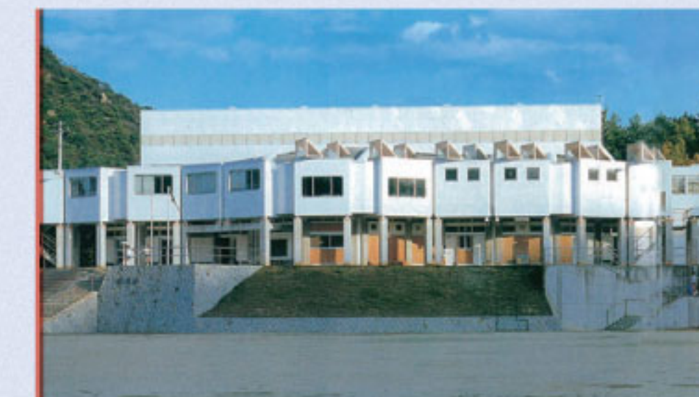
直島中学校体育館・武道館 Naoshima Junior High School Gymnasium/ Gymnasium Martial Arts
